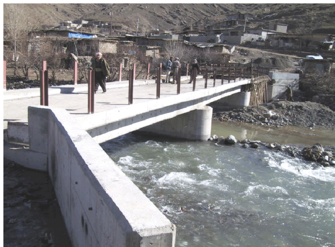
Slika 2: Zgrajenih je bilo veliko novih mostov
