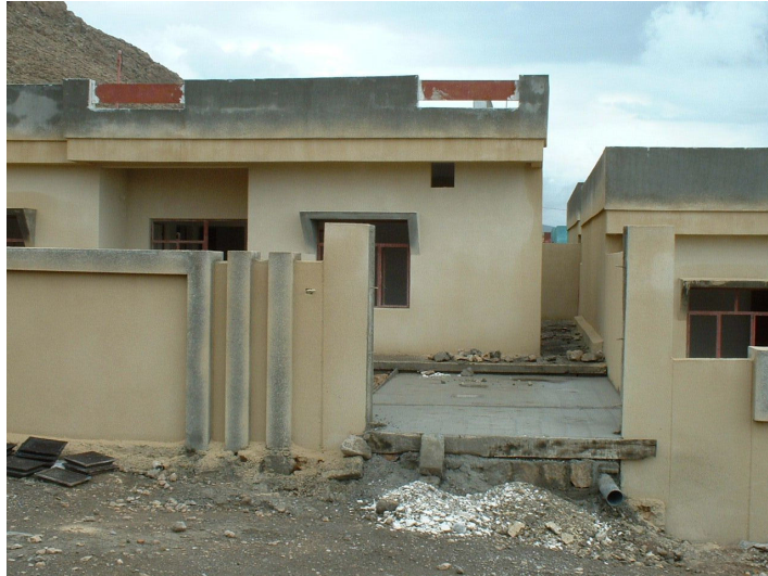
Slika 1: Enodružinska hiša v izgradnji
