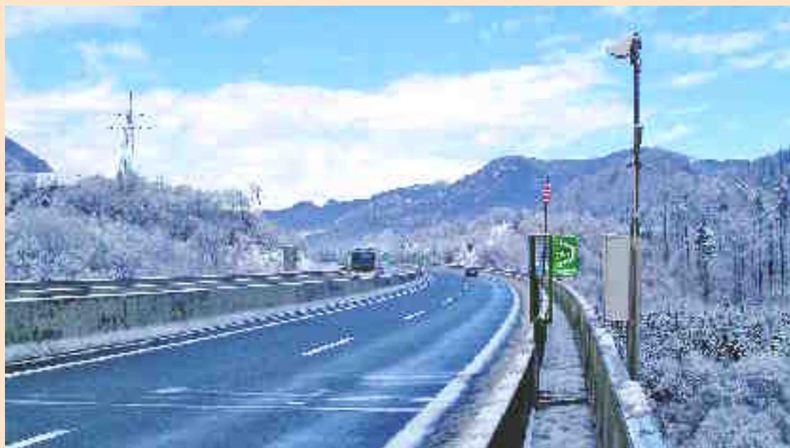
CESTNO-VREMENSKA POSTAJA NA VIADUKTU MOSTE
