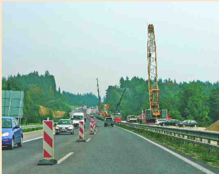
OBNOVA VIADUKTA LEŠNICA – Gradbena dela na viaduktu Lešnica so se začela letošnjo pomlad in bodo končana prihodnje poletje. Vrednost pogodbe je nekaj manj kot pet milijonov evrov.
